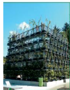
Blickfang im Riedbrunn: Der Platanenkubus. Foto: Stadt
