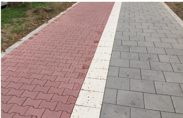
Optisch kontrastierende und taktile Trennung zwischen Geh- und Radweg (30 cm)
